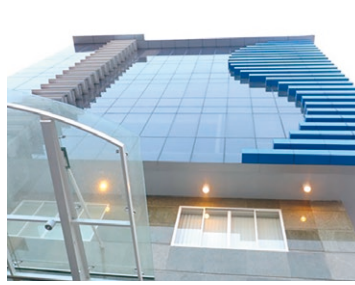
ベトナム・ホーチミンテクノセンター2号館
